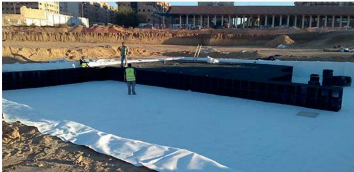
construcción de los depósitos recogida de agua de lluvia con cajas de polipropileno (VPC)
