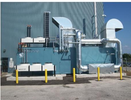
**Figure 7-9. Siemens SGE-36SL, 676 kW**
