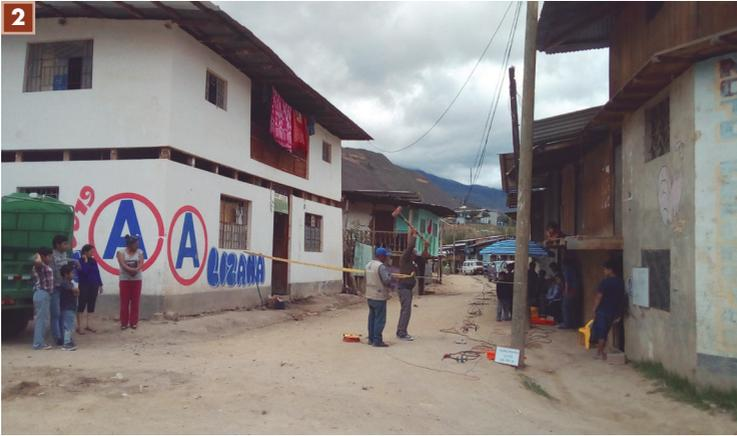
**2.** Barrio Jibaja Ch.: Registro de datos con el método sísmico que permiten identificar espesores de capas y velocidades de ondas a diferentes niveles de profundidad.
