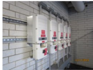
Carport PV 2.JPG
