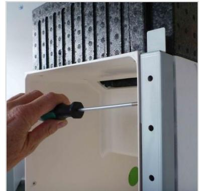
2. Die Schnellbau-Rahmen montieren Sie an der Wand und gegebenenfalls an der Decke mit jeweils 2 Schrauben. Legen Sie bis zu 3 Stück Rund-Flex-Rohre 75 mm oder ein Rund-Rohr 100 mm in die Rahmen ein.
