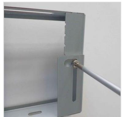
4. Für die Montage der 12,5 mm Trockenbauplatten verwenden Sie am besten selbstschneidenden Schrauben mit Bohrspitze.
